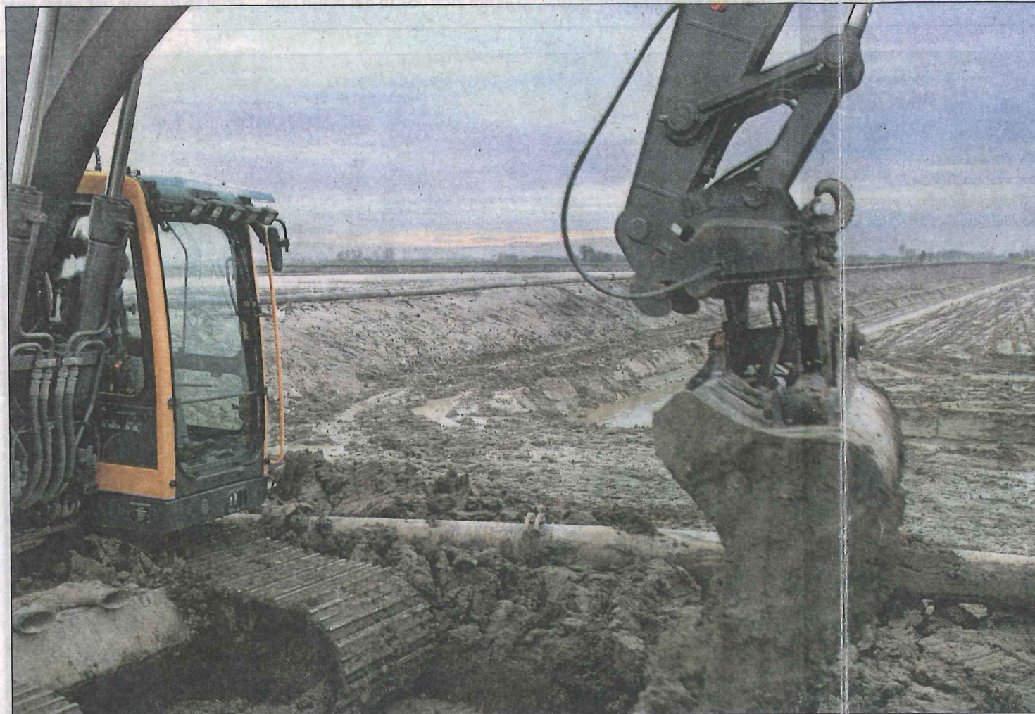
Een kraan verricht de laatste werkzaamheden aan het baggerdepot even buiten Winsum.
