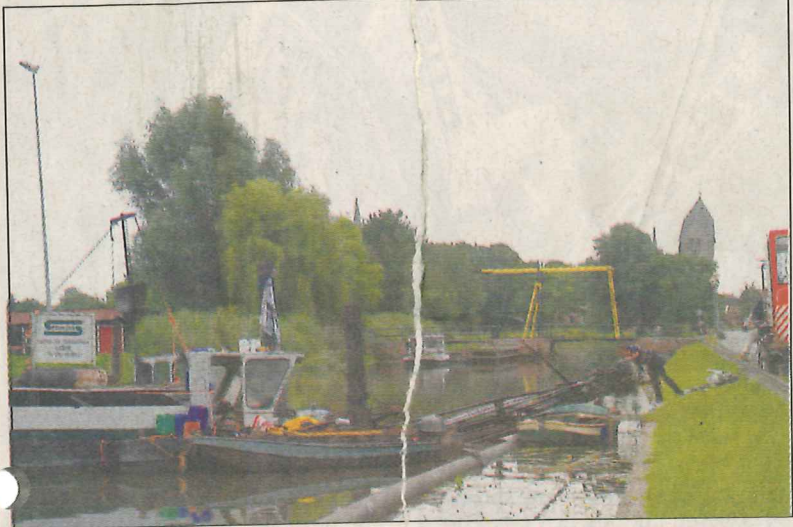
■ Baggerwerkzaamheden in het Boterdiep bij de Terlaansterklap in Bedum.
